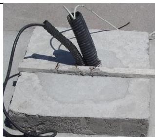
Base se concreto, pronta para receber a cancela.
