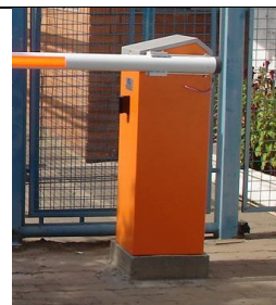
Cancela já instalada na base
